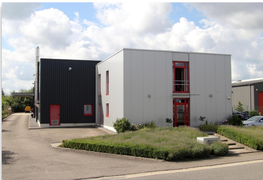
Usine Balteau NDT - 2015
