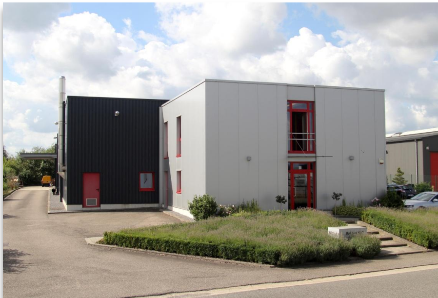
Usine Balteau NDT - 2015
